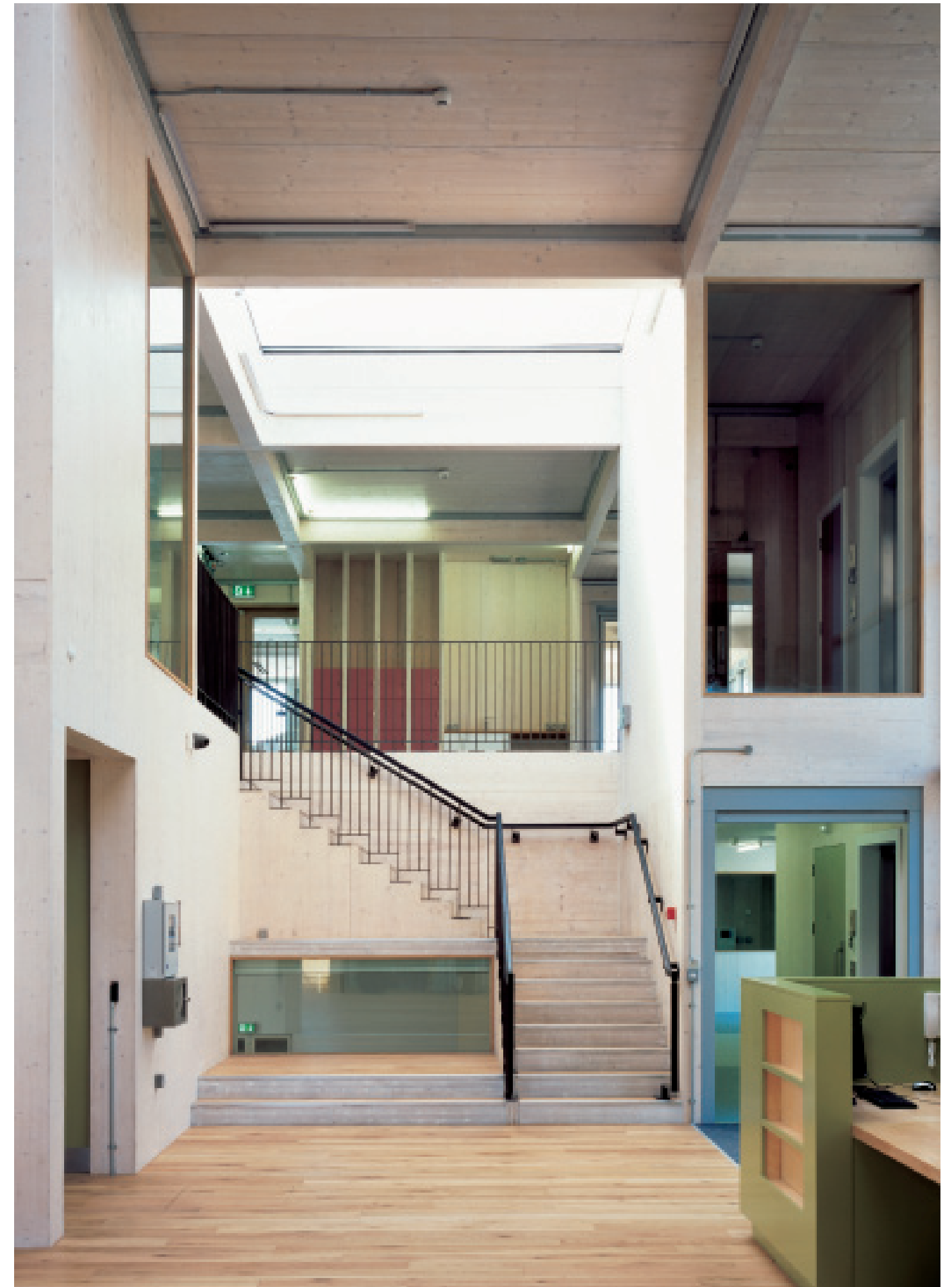
Kaum eine Fläche wurde verkleidet – vom sichtbaren und ökonomischen Tragwerk bis zu den Leitungen ist alles sorgfältig geplant und ausgeführt.
